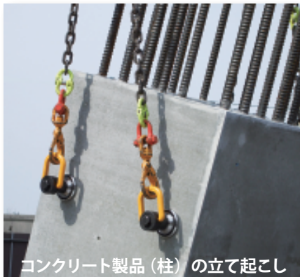
コンクリート二次製品の移動作業
