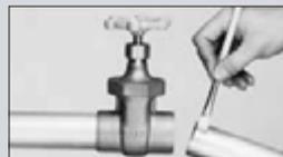
銅管の差込部分の外周にフラックスを薄く均等に塗布し、銅管をバルブ接合部の奥まで一杯に差し込み、さらに1~2回転まわしてよくなじませます。
