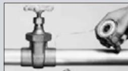
紐状の口付材を図のように接合部に当て、巻きつけるようにしながら加熱トーチで溶解します。融けた口付材は毛細管現象で接合部に均等に浸透して融着します。
